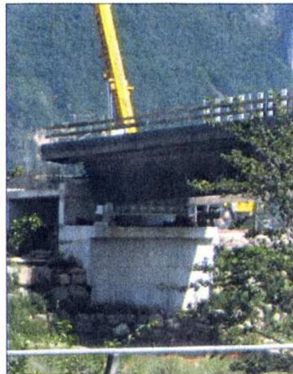
Im Bild die im Bau befindliche Piglon-Brücke.
