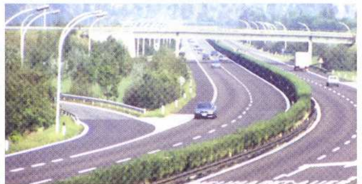
Brennerautobahn: Was passiert bei der Ausschreibung?
