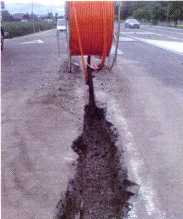
Verlegung des Glasfaserkabels: Das Unterland wird bis 2013 angeschlossen.
