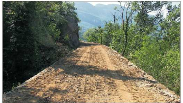
Der derzeit im Bau befindliche Radweg hat in Auer eine Breite von zwei Metern (linkes Bild im Bereich Bahnhofstraße), bei Castelfeder eine Breite von 2,5 Metern (rechtes Bild). jo
