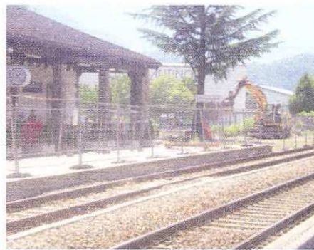
Bahnhof Auer: Jetzt wird gearbeitet
