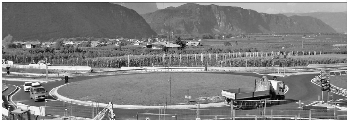
Der neue Kreisverkehr von Auer Nord hat einen Durchmesser von 52 Metern. Er regelt die Zufahrten von der Umfahrungsstraße in das Dorf Auer sowie in das Gewerbegebiet Süd/Ost. jo
