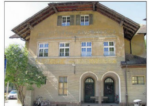
Die Gemeinde Auer will den Bahnhof sanieren, sobald dieser vom Land in den Besitz der Gemeinde übergeht, kündigte Bürgermeister Roland Pichler gestern an. jo
