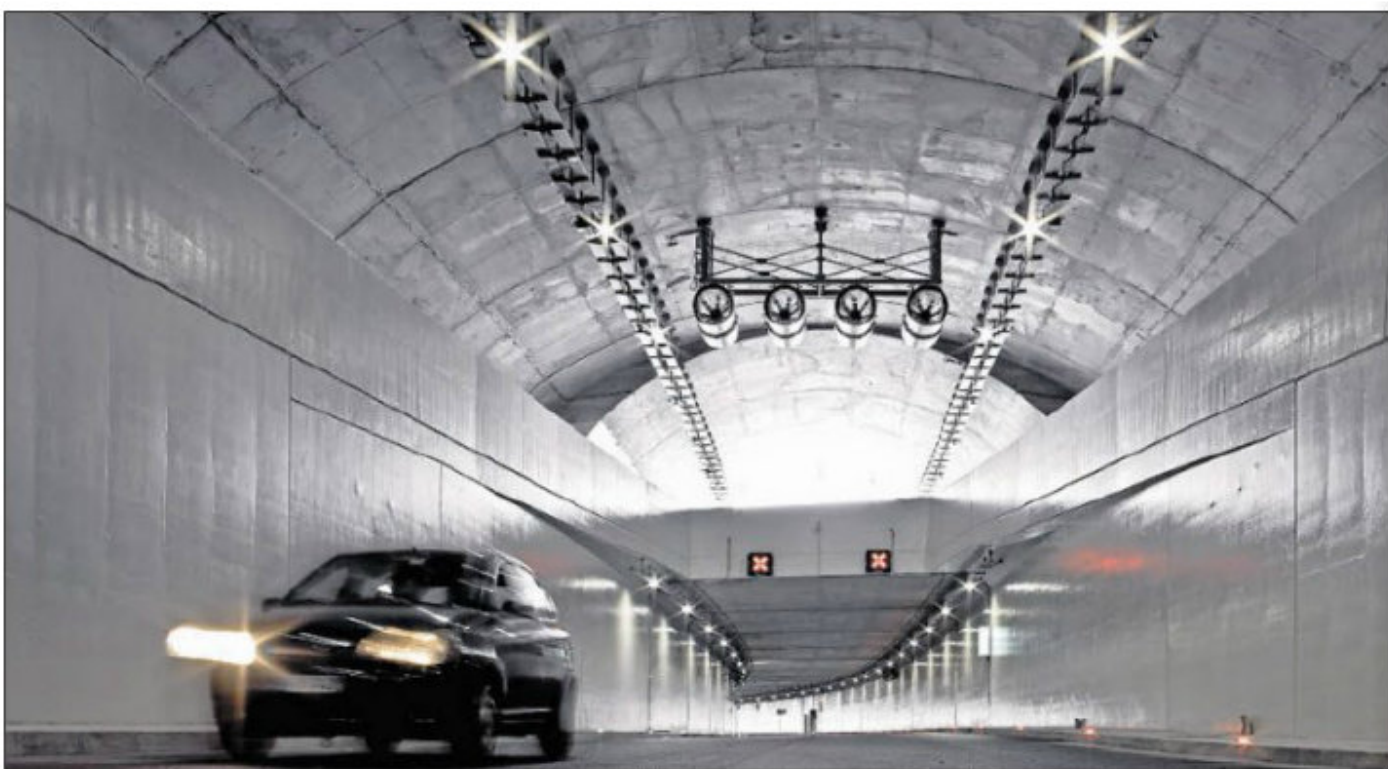
Besondere Aufmerksamkeit wurde beim Bau des Tunnels auf die Sicherheit gelegt. LED-Leuchten, Ventilatoren, Videokameras sowie Hydranten- und Feuerlöscher-Nischen gehören zur Ausstattung. Alessandra Chemollo
