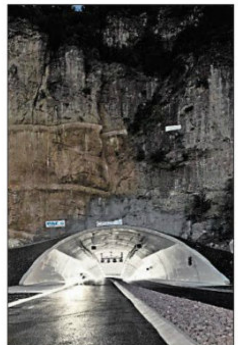
Im Rahmen der Bauarbeiten zu den Portalen des St.-Daniel-Tunnels wurden auch die längst notwendigen Hangsicherungsarbeiten durchgeführt.
