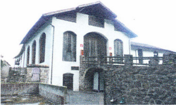
Happacherhof: Vor dem Umbau, nach dem Umbau
