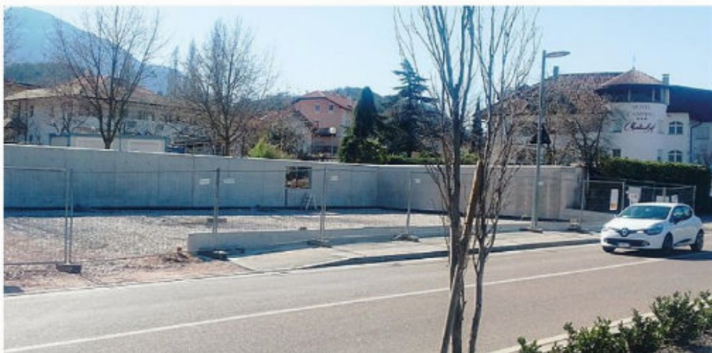
Il parcheggio con 20 posti auto che passerà al Comune di Ora in cambio del raddoppio del campeggio Markushof
