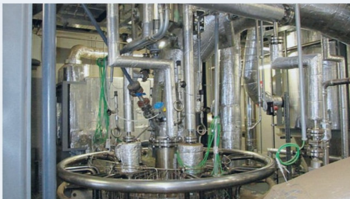
L'interno dell'impianto: non ci sono turbine, ma un motore che funziona con un gas di sintesi
