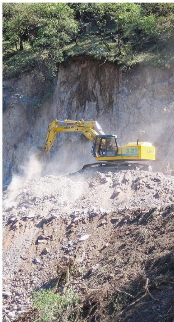
I primi lavori per la realizzazione della circonvallazione di Ora
