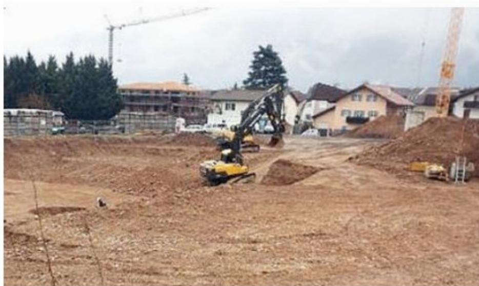
Iniziati i lavori di scavo nella zona residenziale «Palain» ad Ora
