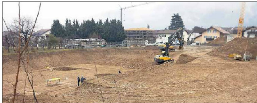
Das alte Sägewerk wurde abgerissen und nun sind die Arbeiten für den Bau der Infrastrukturen und der Tiefgarage angelaufen.
