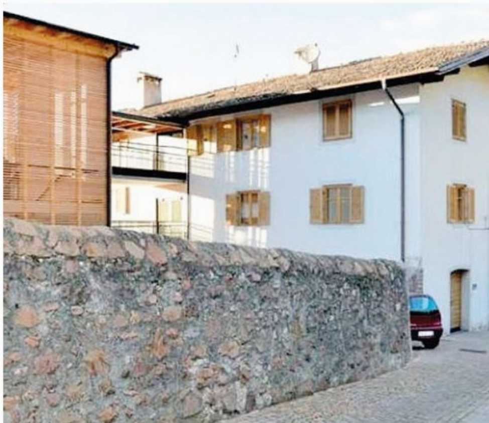
Procedono i lavori per la realizzazione dei mini-alloggi per anziani ad Ora (Foto Peter Simonini-Notiziario comunale)
