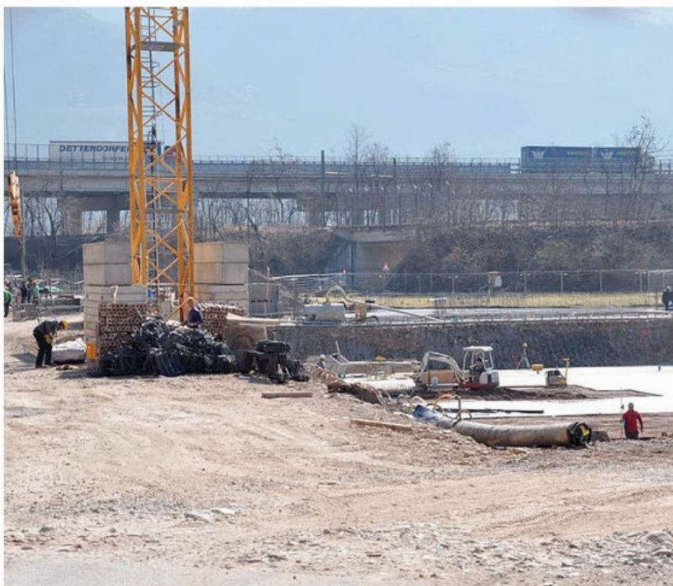
Il cantiere per la maxi-lavanderia dell'Asl a Vadena ; l'appalto è stato vinto dalla Haas di Ora (Foto Canali)
