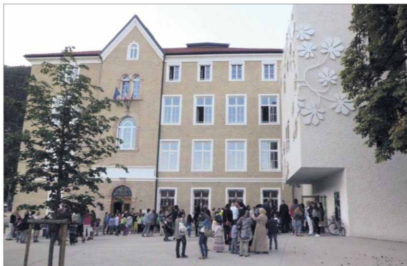
Im Bild Schüler und Eltern vor der sanierten sowie um- und ausgebauten Volksschule von Auer.
