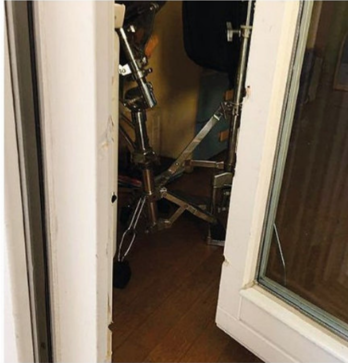
L'infisso forzato sul balcone di uno degli alloggi colpiti (Foto Conti)
