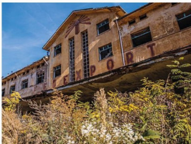
L'edificio ex Fedexport in via Stazione ad Ora
