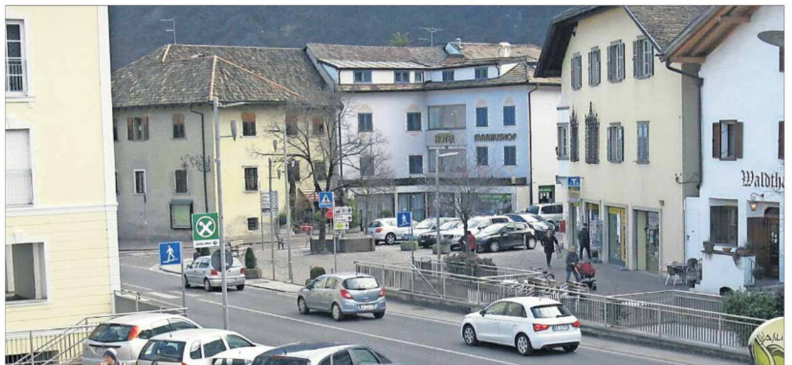
Die Gemeinde Auer legt im heurigen Jahr bei den Investitionen ihr Hauptaugenmerk auf die Umsetzung des Verkehrs- und Parkplatzkonzeptes am Hauptplatz (im Bild). Gemeinde Auer
