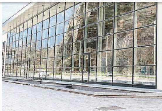
Il capannone della lavanderia industriale dell'Asl a Vadena
