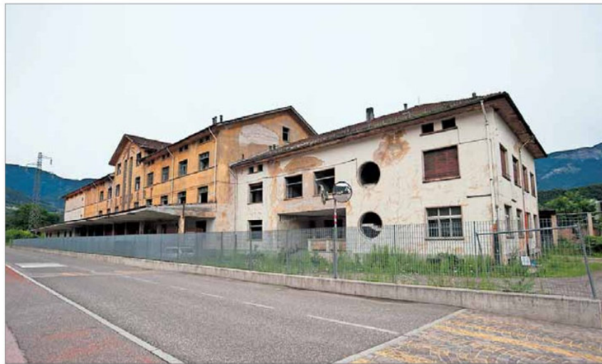
In dieser ehemaligen Obstlagerhalle in Auer sollen bald Asylsuchende einziehen.
