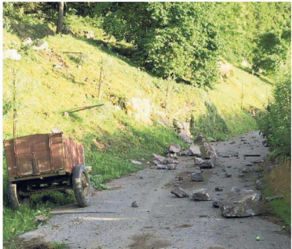
La frana caduta dal monte di Ora in zona «Fuchsloch» (Foto Vigili del fuoco di Ora)
