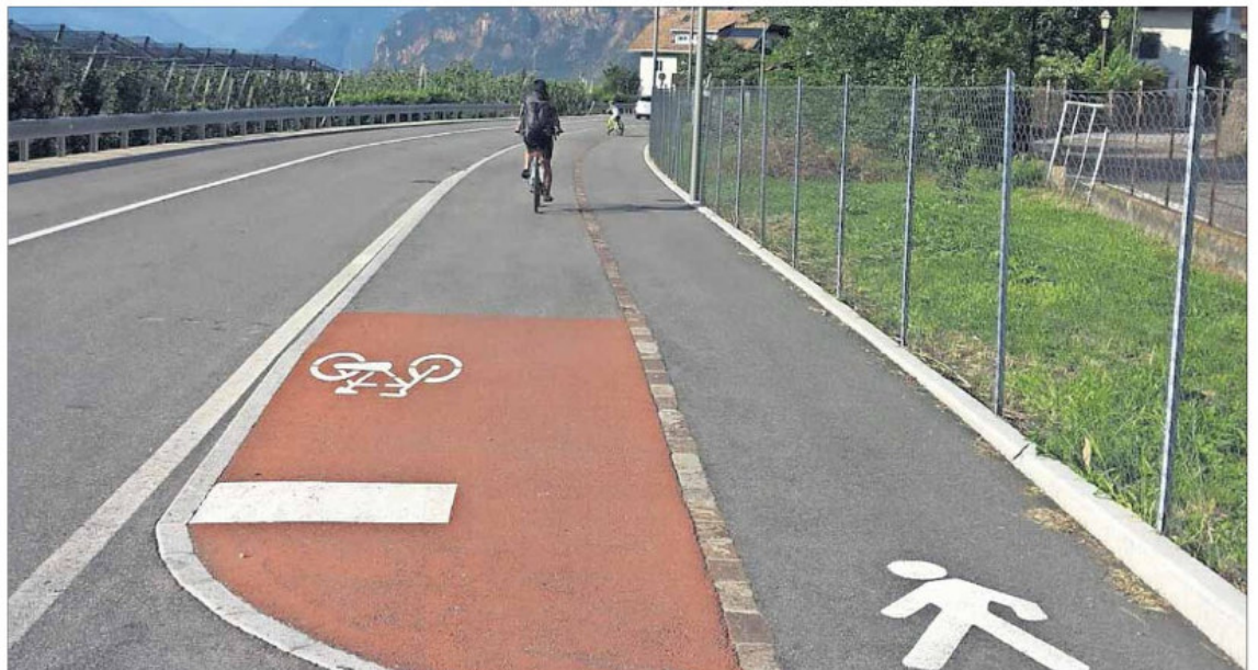
Die Grundstücke, die es für den Bau des Radweges in Auer (im Bild) brauchte, werden abgelöst. Der Gesamtbetrag wurde um 20.000 Euro erhöht.
