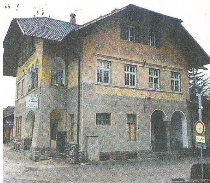
L'edificio ex Stazione di Ora
