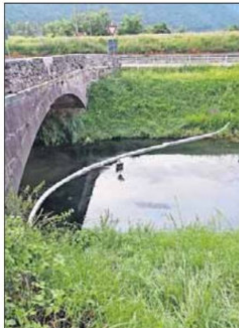
Mittels Ölsperren wurde die Flüssigkeit aufgesaugt. FFW Branzoll
