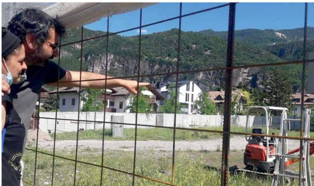
• Iniziat i lavori di scavo nella zona residenziale «Palain» a Ora per la cooperativa Eden: previsti 7 alloggi
