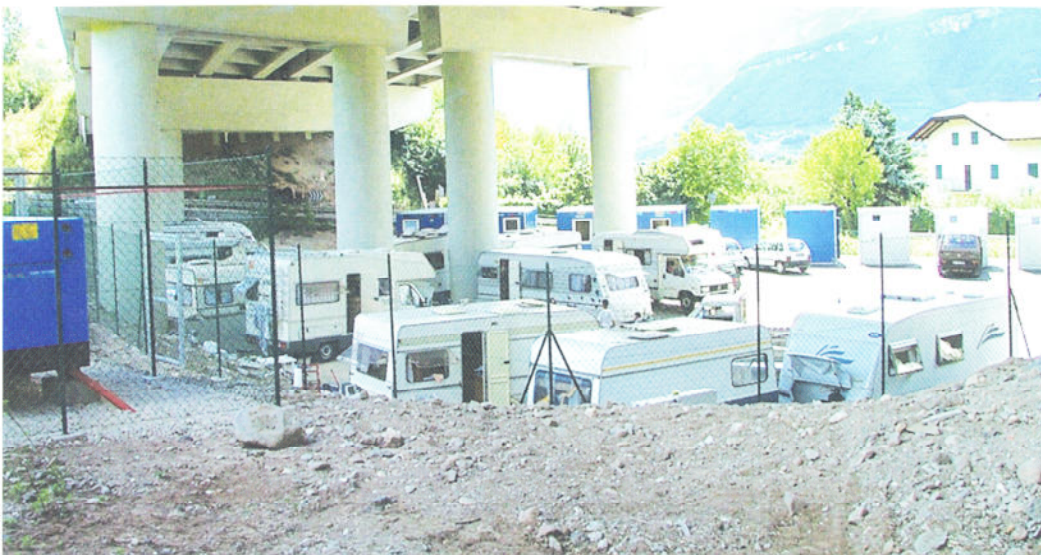
Sinti-Lager in Pfatten: Es leben noch 13 Personen unter dem Viadukt
