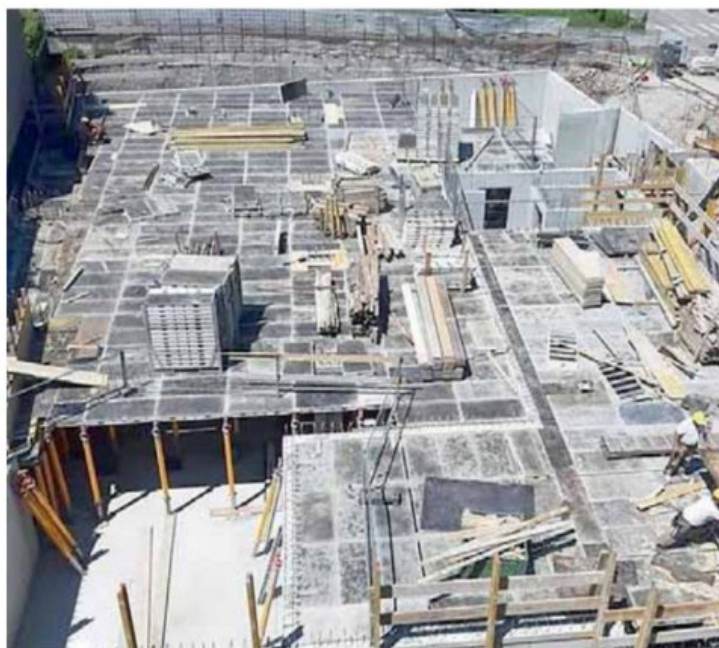
• I lavori per la costruzione di edifici realizzati in cooperativa
