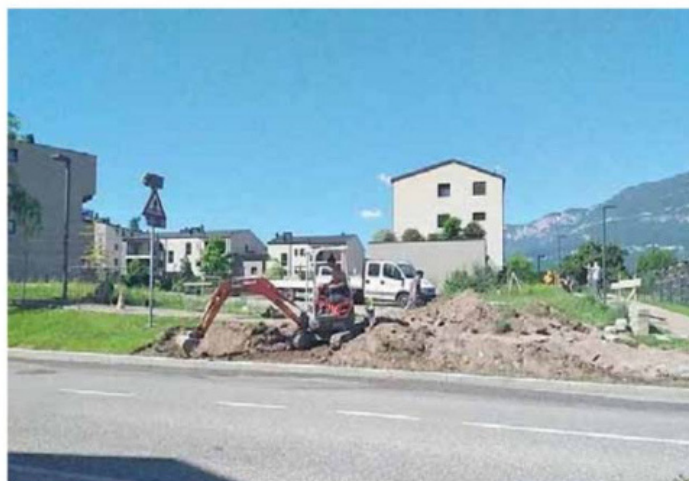
• Scavi in corso nella zona Palain a Ora
