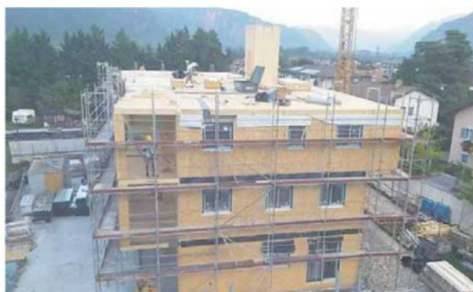
• Lavori in dirittura d'arrivo alla coop Eden in zona Palain a Ora
