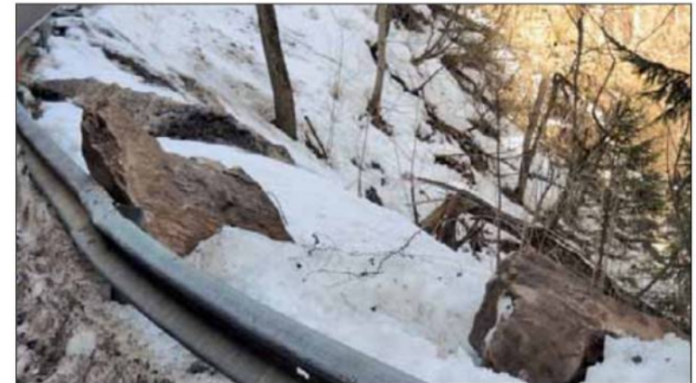
Ebenfalls in der Nacht hatten sich Gesteinsblöcke im Bereich der Straße Mühlen-Gschnon gelöst. Sie blieben neben der Fahrbahn liegen.
