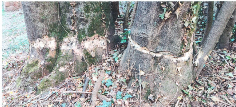
Mit einem Beil beschädigt: Insgesamt neun Bäume betroffen
