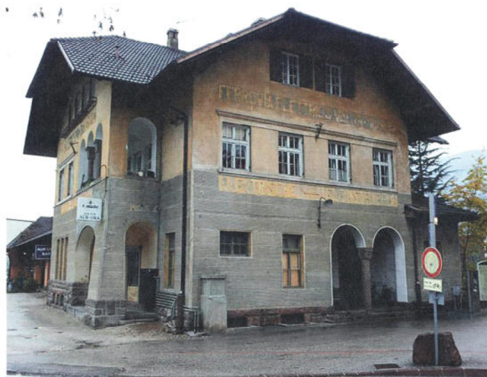
Ehemaliger Bahnhof der Fleimstalerbahn: Muss saniert werden
