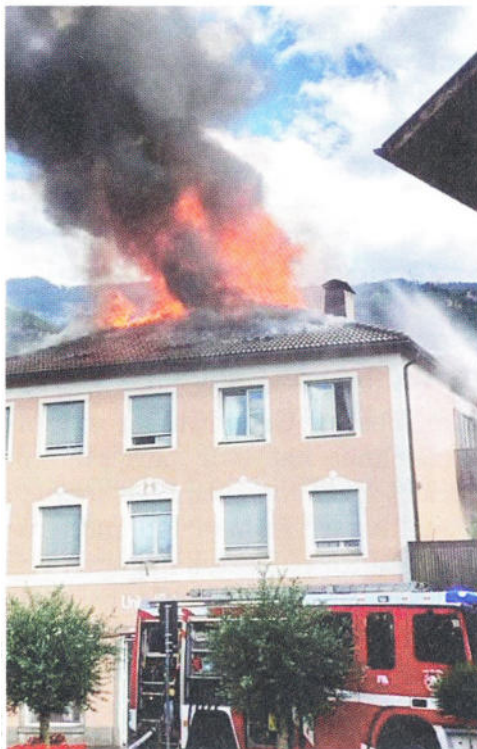
Brand im Zentrum von Auer: Dachstuhl komplett abgebrannt
