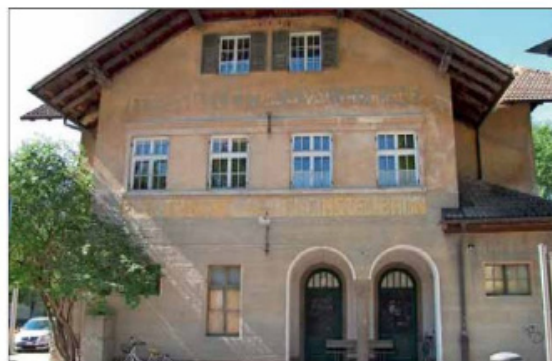
Die Sanierung des ehemaligen Bahnhofes der Fleimstalbahn ist geplant.
