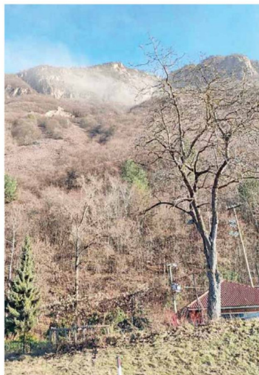
• La montagna sopra Ora da cui si è staccata la frana
