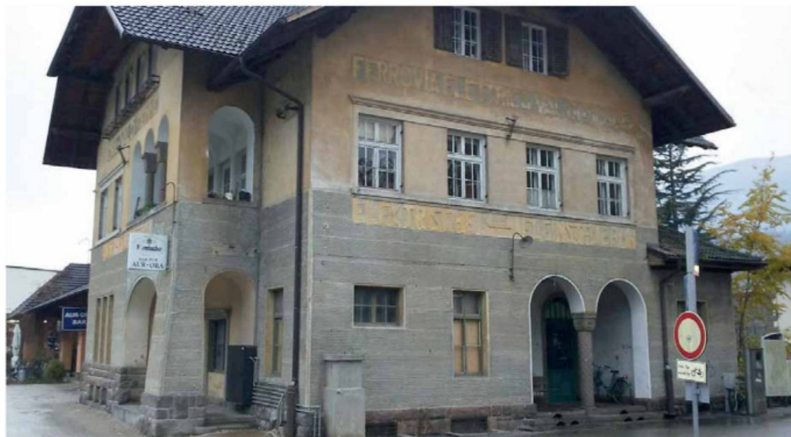
• L'ex stazione ferroviaria della Val di Fiemme a Ora: per il progetto di valorizzazione si punta ai soldi del Pnrr
