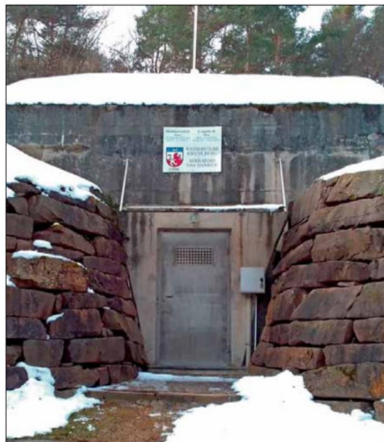
Die Trinkwasserhauptleitung von Glen bis zu den Wasserstuben Kiechlberg soll erneuert werden.
