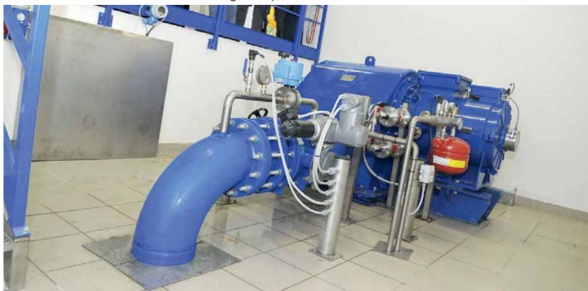
• La turbina che produce l'energia elettrica all'interno di una piccola centralina alimentata dall'acqua di sorgente
