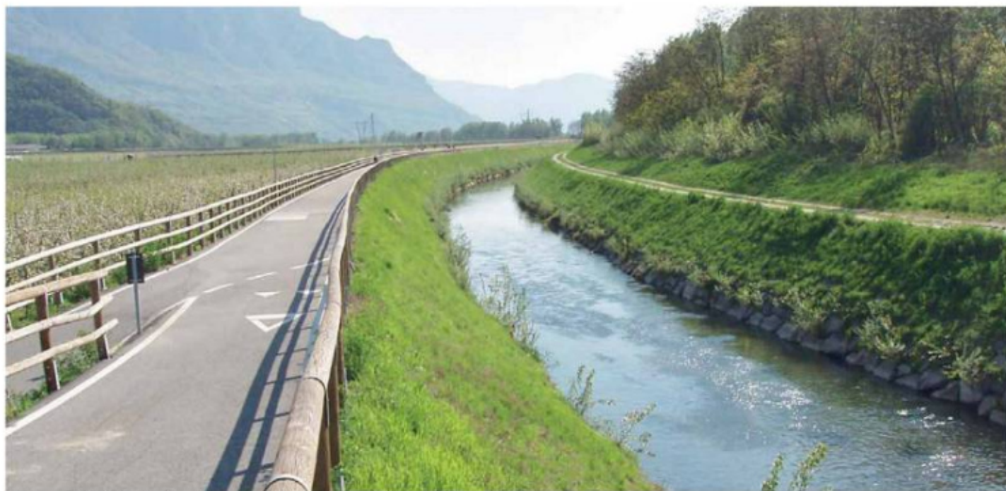
• La fossa grande di Bronzolo: il canale necessita di un intervento per migliorare il deflusso dell'acqua
